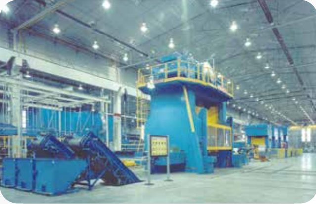
Fabrika Uygulaması: Seri Yakıclı Sistem - Genel Isıtma
