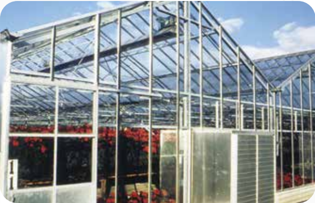
Sera Uygulaması: Seri Yakıclı Sistem - Genel Isıtma
